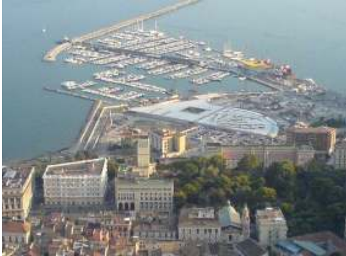
Inizio dei lavori per la costruzione del Crescent, Luglio-Agosto 2010. Foto ricavata dal sito del Comitato NoCrescent.
